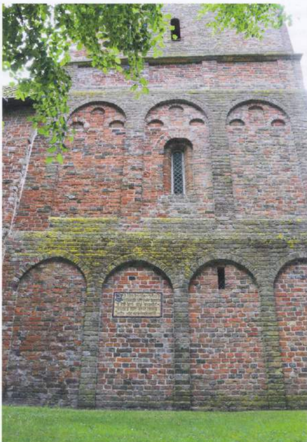
Afb. 3. De noordmuur van de scheefstaande romaanse toren. Foto: Reinout Krajenbrink.
