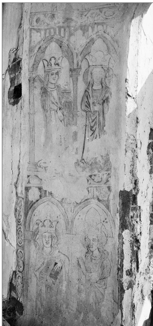
Dagkant middelste koorvenster met vier vrouwelijke heiligen, linksboven mogelijk Barbara (1959)
