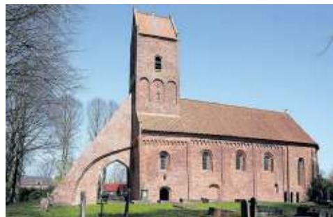
De enorme steunbeer houdt de toren op zijn plek. beeld Sjaak Verboom
