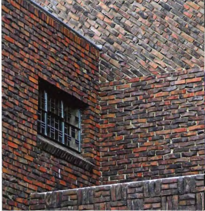
3 Zoals gebruikelijk bij veel kerken die Reitsma bouwde, paste hij ook hier verschillende metselverbanden toe. In combinatie met diepliggend voegwerk zorgde dat voor een rijke schaduwwerking en kregen de gevels een expressief en levendig karakter. Foto David Woltinge.
