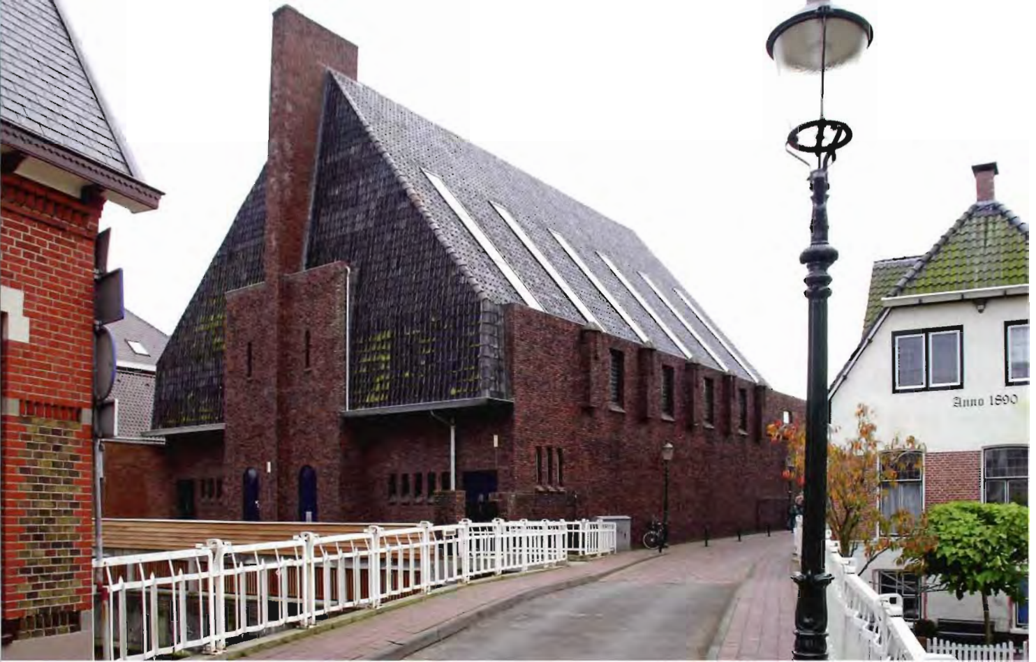
2 Blikvanger is de hoog opgemetselde middenpartij van de gevel aan het diep waaruit een grote schijf tot boven het dak is doorgetrokken. Het zadeldak is zo sterk afgewolfd dat de dakpannen daar als gevelbekleding werken, een belangrijk kenmerk van de Amsterdamse School. Foto David Woltinge.
