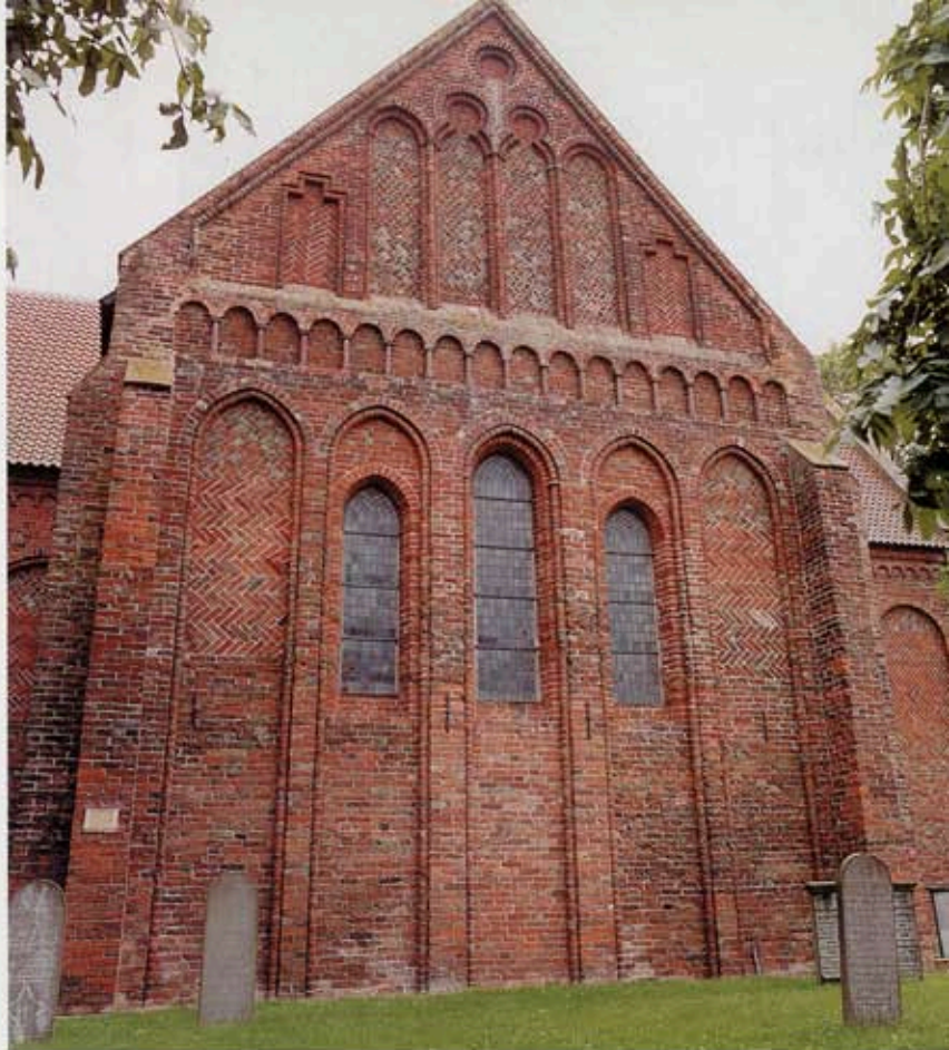
9 In de nissen van de oostgevel van de kerk in Garmerwolde gaat het staande keperwerk in strekken over in een staand keperwerk in koppen.
