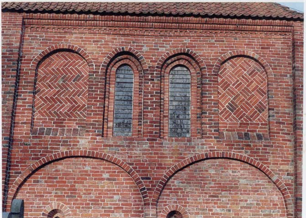
13 Voorbeelden van gevarieerd siermetselwerk zijn ook de gevels van de Opwierder kerk. Hier een deel van de zuidgevel.
