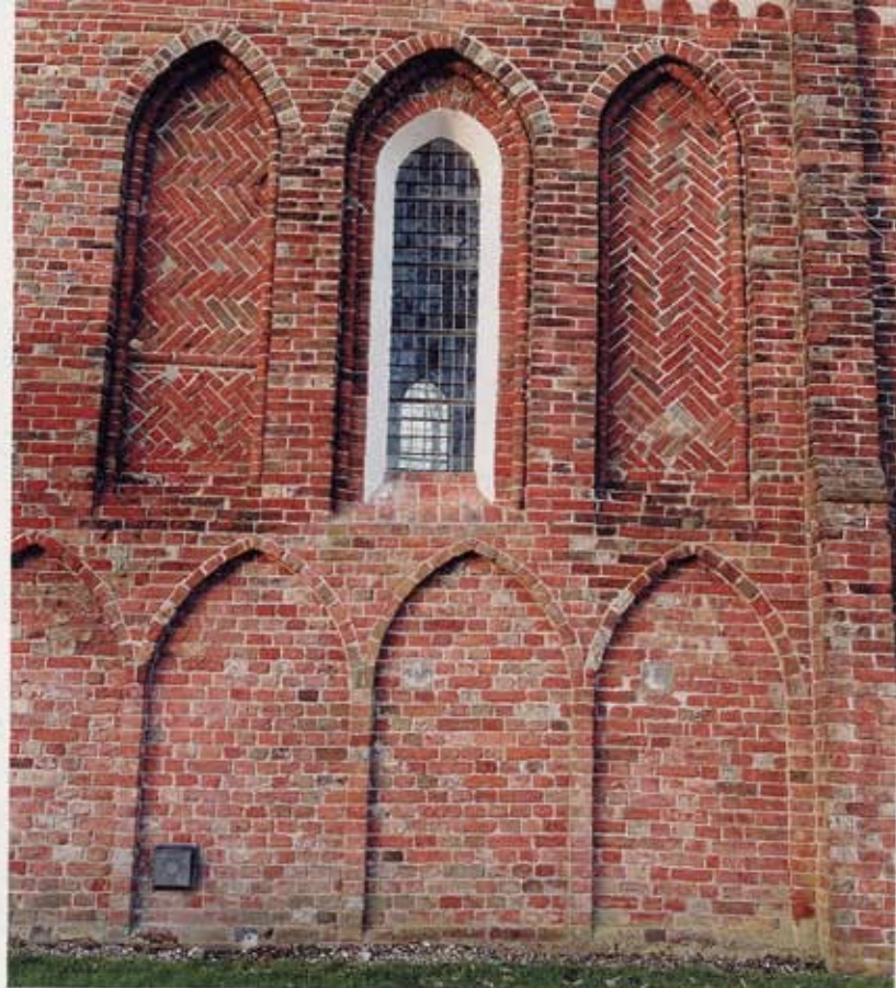
7 In Krewerd is in verschillende nissen het oorspronkelijk siermetselpatroon voor een ander verlaten. Hier twee voorbeelden in de zuidgevel van de westelijke travee.
