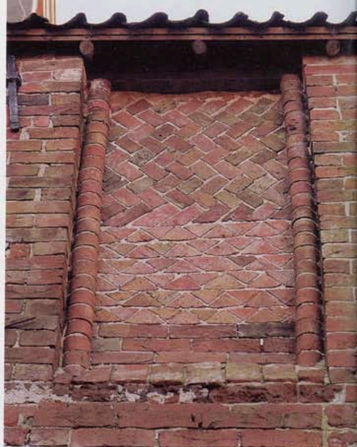
8 Ook in een nis in de noordgevel van het koor van de Thesinger kloosterkerk zijn twee verschillende soorten siermetselwerk toegepast.
