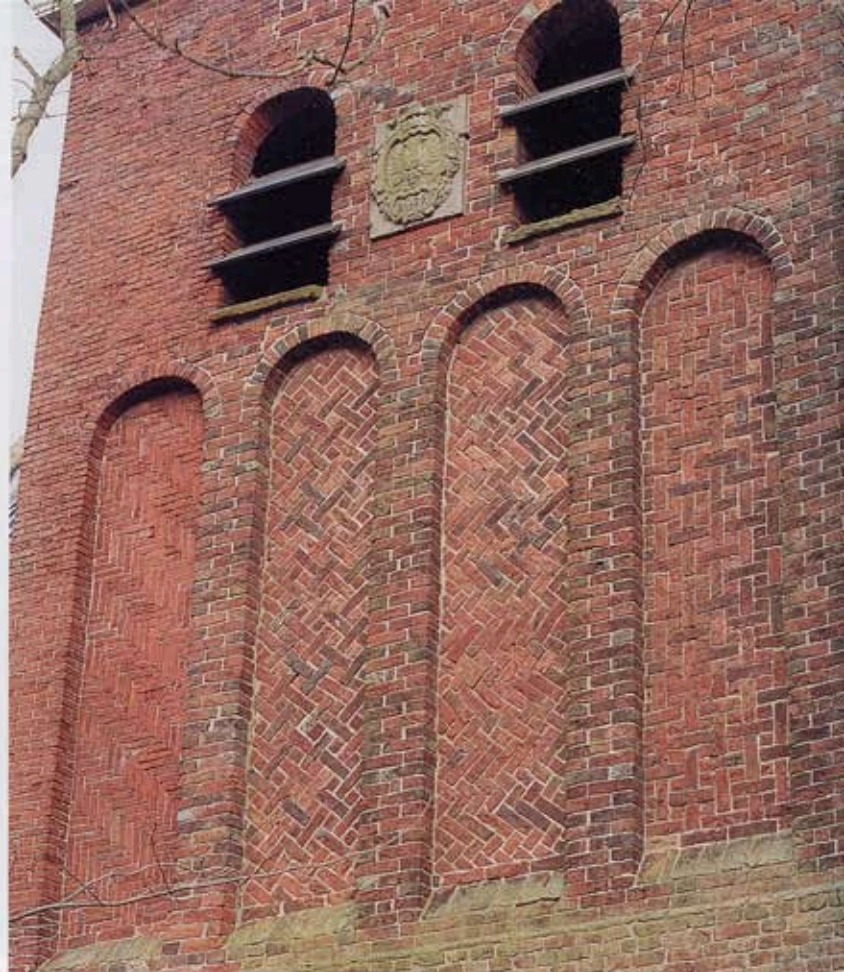
12 De zuidgevel van de toren in Harkstede toont niet alleen vier verschillende siermetselpatronen, maar ook het zorgvuldige zeventiende-eeuws herstel van de zuidwesthoek.
