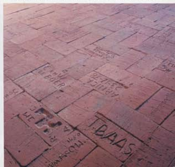
2. Een deel van de vloer op de eerste verdieping van de toren in Uitwierde, gemetseld met in 1991 ingegrifte bakstenen.
